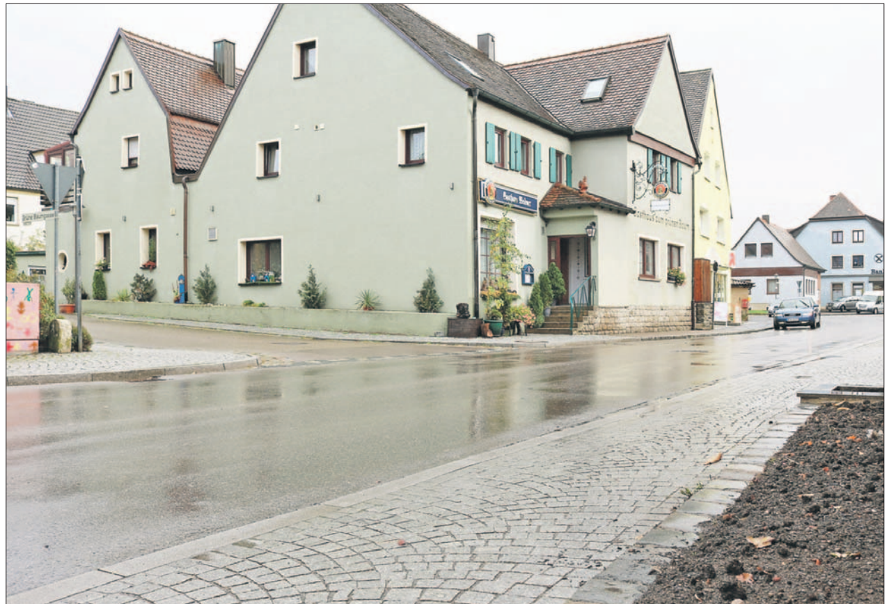
In diesem Bereich sollen Fußgängerampel und Querungshilfe errichtet werden.
